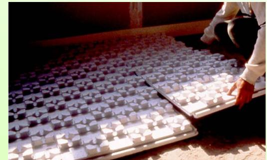
1. Les plots intégrés à l'isolant servent de fixation aux tubes. Leurs espacements permet de poser les tubes au pas déterminé par le bureau d'étude.
