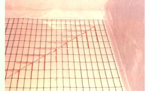
Poser le treillis et le fixer pour qu'il ne bouge plus.
