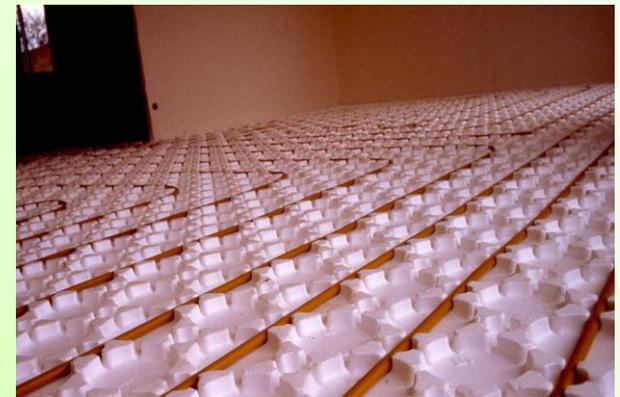
C'est une plaque de polystyrène spécifique sans plot de fixation.
